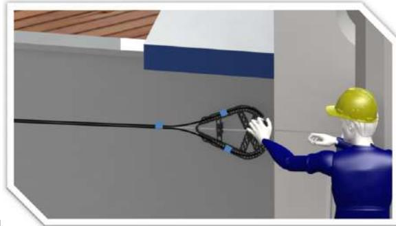
Colocar la otra raqueta de ..... (.....ente) con la cantidad de cable que se requiera almacenar. La cantidad de cable a almacenar va en función de la reserva ya hecha.
