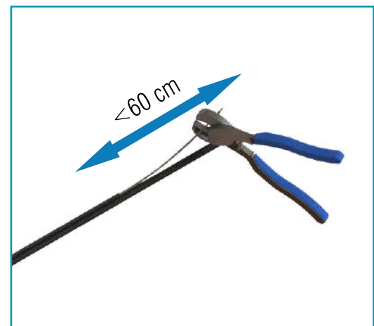
Imagen 10: Corte para colocar un preformado
