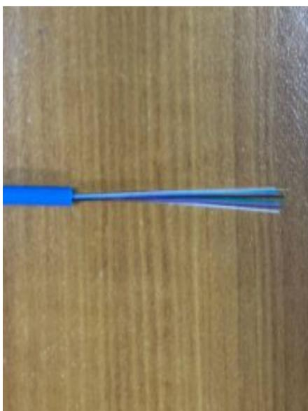
12. Desforre el tubo holgado utilizando el cortador apto. Si el cable tiene componente en gel, proceder con su limpieza.
