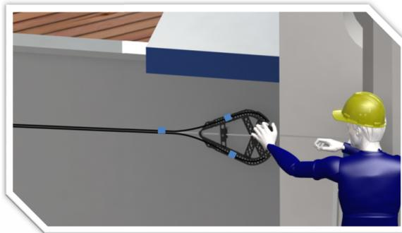
Colocar la otra raqueta de almacenamiento de cable (como ya se menciono anteriormente) con la cantidad de cable que se requiera almacenar. La cantidad de cable a almacenar va en función de la reserva ya hecha.
