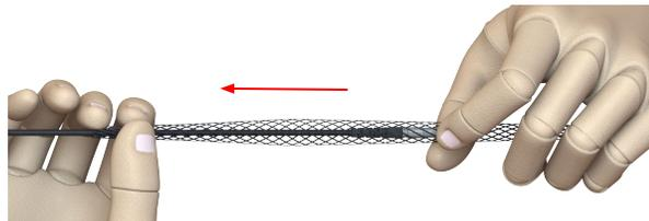
**Paso 16:** Repita la acción anterior hasta que la malla de jalado se inserte en el cable de fibra óptica por 60 cm, por último se aplanará la malla.
